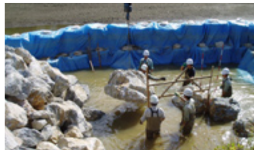
大保試験施工 (H17.10.20)
